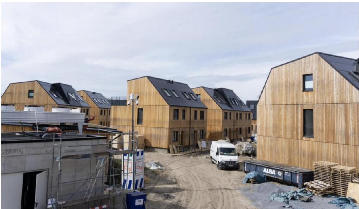
Die meisten Häuser stehen bereits. Noch fehlt die Begrünung (naturstrom AG)
