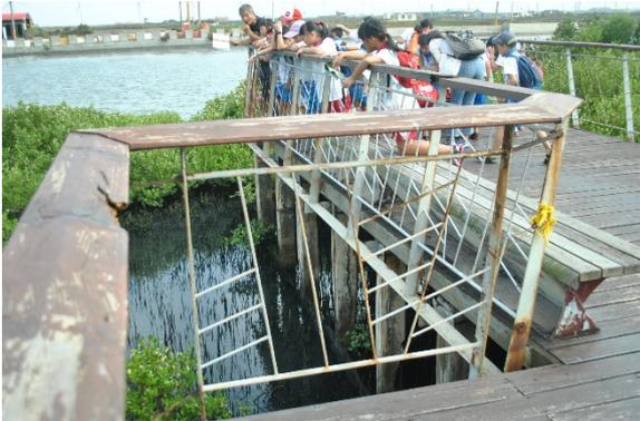
生態步道扶手及底部梁柱已風化生鏽
