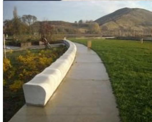
利用造型座椅取代現有金屬欄杆，除了可以作為遊客欣賞漁港的座椅空間，並可作為行車的安全車阻
