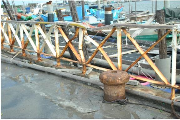
漁港護欄已損壞
