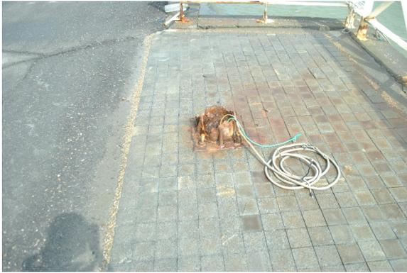
照破損燈座殘骸並未移除
