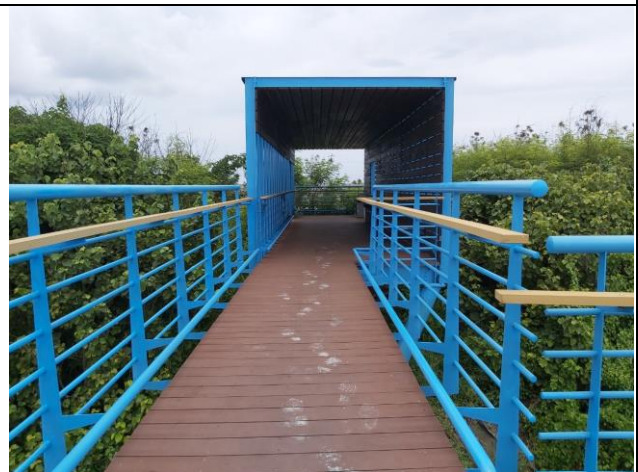
拍攝時間：109/06/30 施工項目：觀景休憩區改善工程
