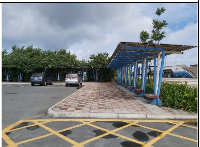
拍攝時間：109/06/30 施工項目：停車場改善工程
