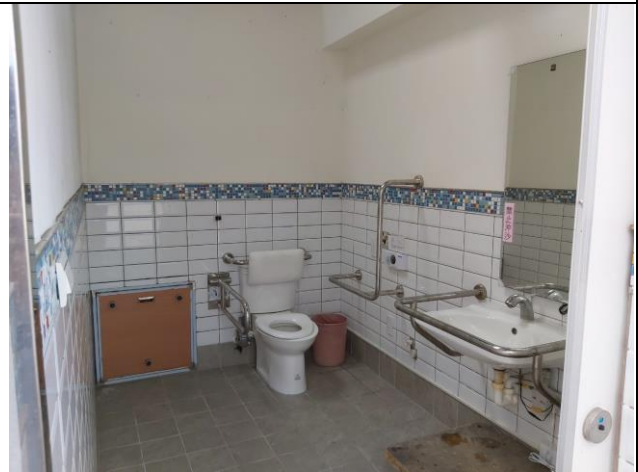
拍攝時間：109/06/30 施工項目：公廁改善工程
