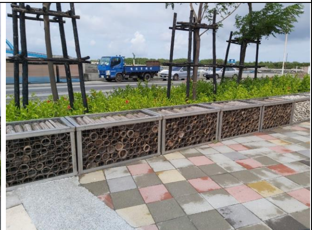
拍攝時間：109/06/30 施工項目：綠化植栽改善工程
