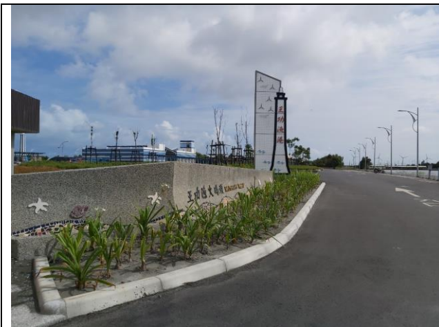
拍攝時間：109/06/30 施工項目：入口改善工程
