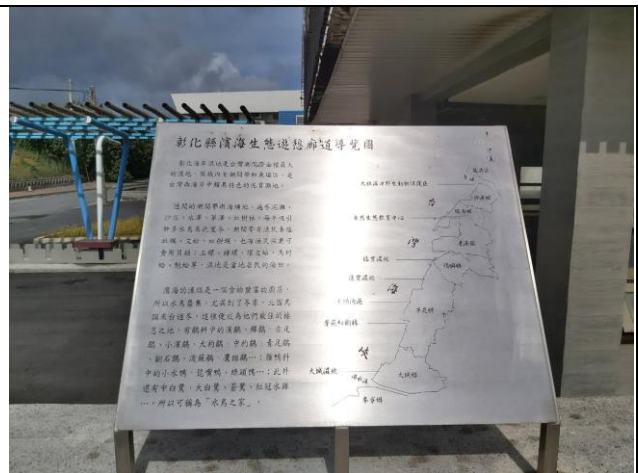
拍攝時間：109/06/30 施工項目：入口改善工程
