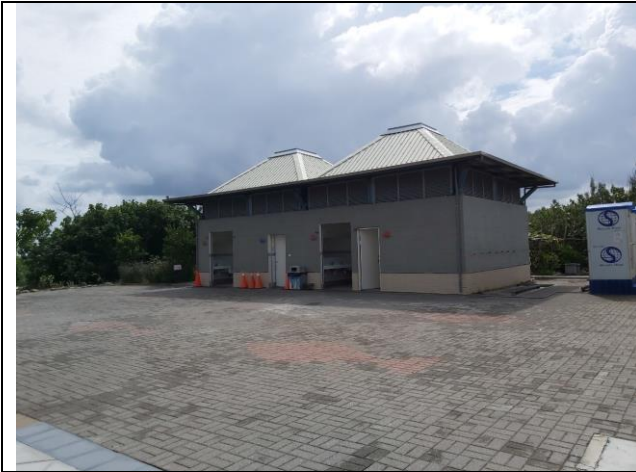
拍攝時間：109/06/30 施工項目：公廁改善工程
