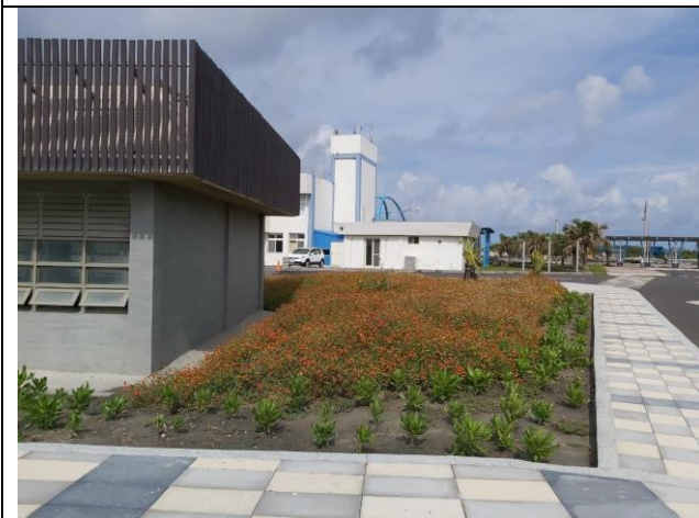
拍攝時間：109/06/30 施工項目：入口改善工程
