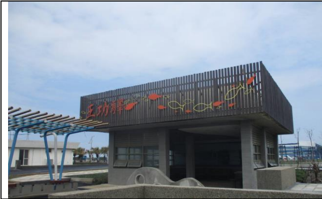
拍攝時間：109/06/30 施工項目：入口改善工程
