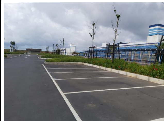
拍攝時間：109/06/30 施工項目：停車場改善工程
