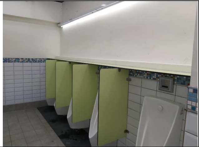
拍攝時間：109/06/30 施工項目：公廁改善工程
