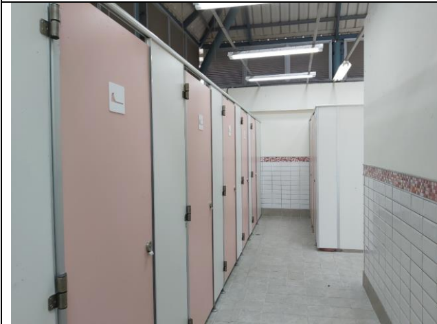
拍攝時間：109/06/30 施工項目：公廁改善工程
