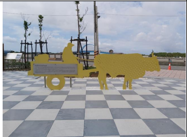
拍攝時間：109/06/30 施工項目：服務區及風貌廊道改善工程
