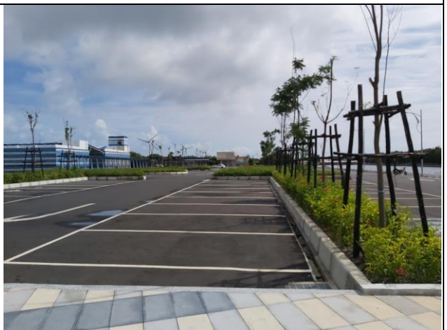
拍攝時間：109/06/30 施工項目：停車場改善工程
