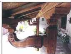
veranda met bewerkte houten consoles
