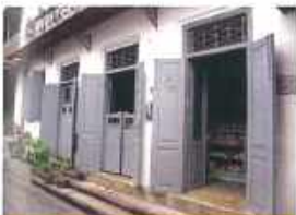
Woning in Kauman met dubbele deuren, sierlijke bovenlichten en ijzeren consoles
