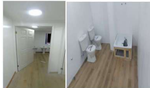
Construcción baños Colegio Mercedes Maturana Gallardo de Catapilco
