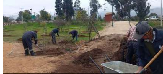
Mejoramiento de Plaza Cesfam de Catapilco
