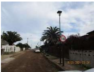
Mejoramiento Iluminación Calle Los Maitenes, La Laguna
