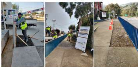
Reparación Veredas localidad de Zapallar, Cachagua y Catapilco
