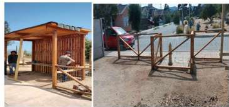
Construcción cierre y paradero de Catapilco
