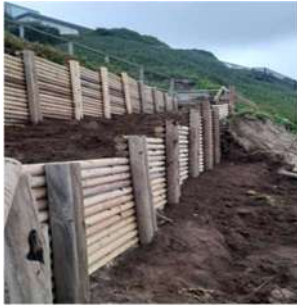
Reparación bajadas públicas Beranda y Los Duendes, Zapallar
