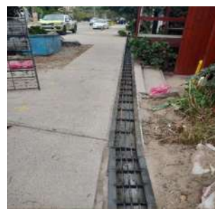
Construcción encauce aguas lluvias Olegario Ovalle Zapallar
