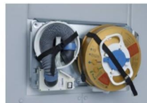
▲「最後の砦」避難屋導入Rainbow 72R空氣過濾器，能去除室外空氣中99.995%的有害物質，防止放射性物質或化學毒氣入侵。
