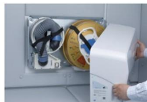
▲「最後の砦」避難屋導入Rainbow 72R空氣過濾器，能去除室外空氣中99.995%的有害物質，防止放射性物質或化學毒氣入侵。
