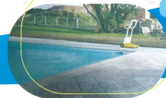
Finitions et mise en eau
