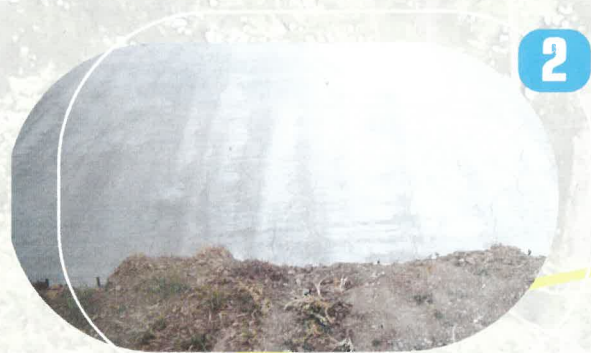
Réalisation de la chappe
