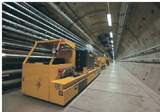
XFEL 加速器地下トンネル
