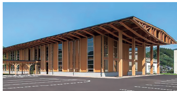
木材活用の例 (岩手県 住田町役場)
