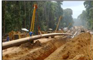
5 – Mise en fouille
