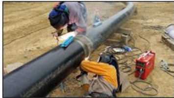
3 – Soudage des tubes
