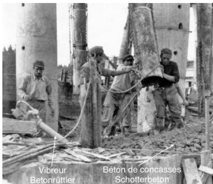
Einbringen des Betons mittels eines Rüssels. Links erkennt man den eigens für diese Baustelle entwickelten Rüttler zum Verdichten des Betons.
