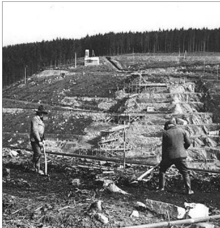
Während im Februar 1937 die Erdarbeiten am rechten Ufer im Gange sind, ist das Roden der Baumstümpfe am linken Ufer noch nicht abgeschlossen.
