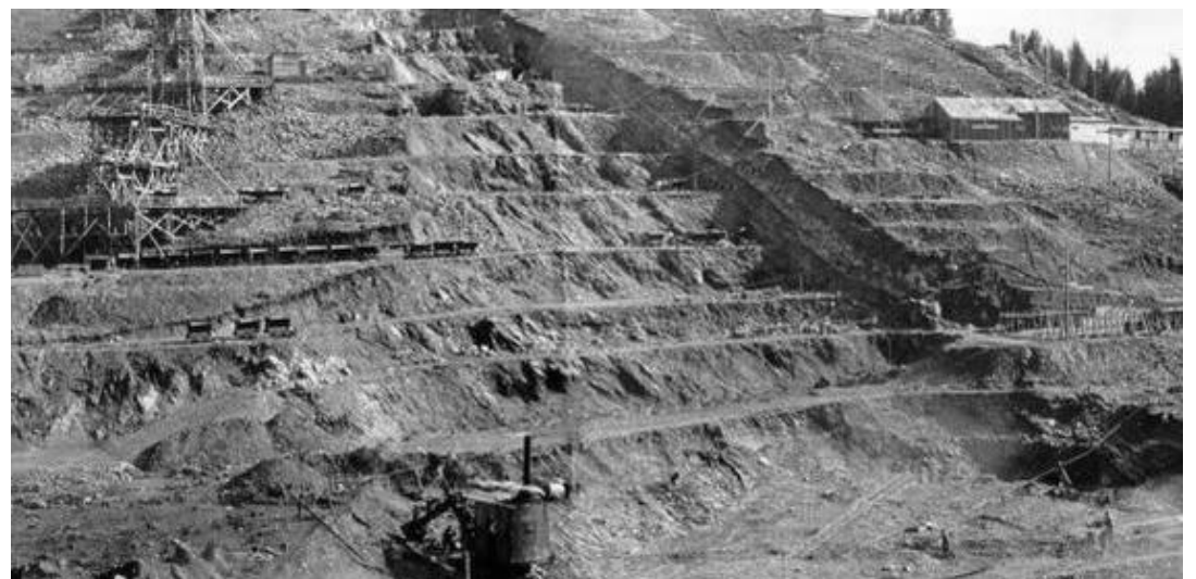
Dieses Foto zeigt an der rechten Uferseite zehn Angriffsflächen im Felsen und das Holzgerüst zum Abtransport des Abraums. Foto: Eupener Geschichts- und Museumsverein
