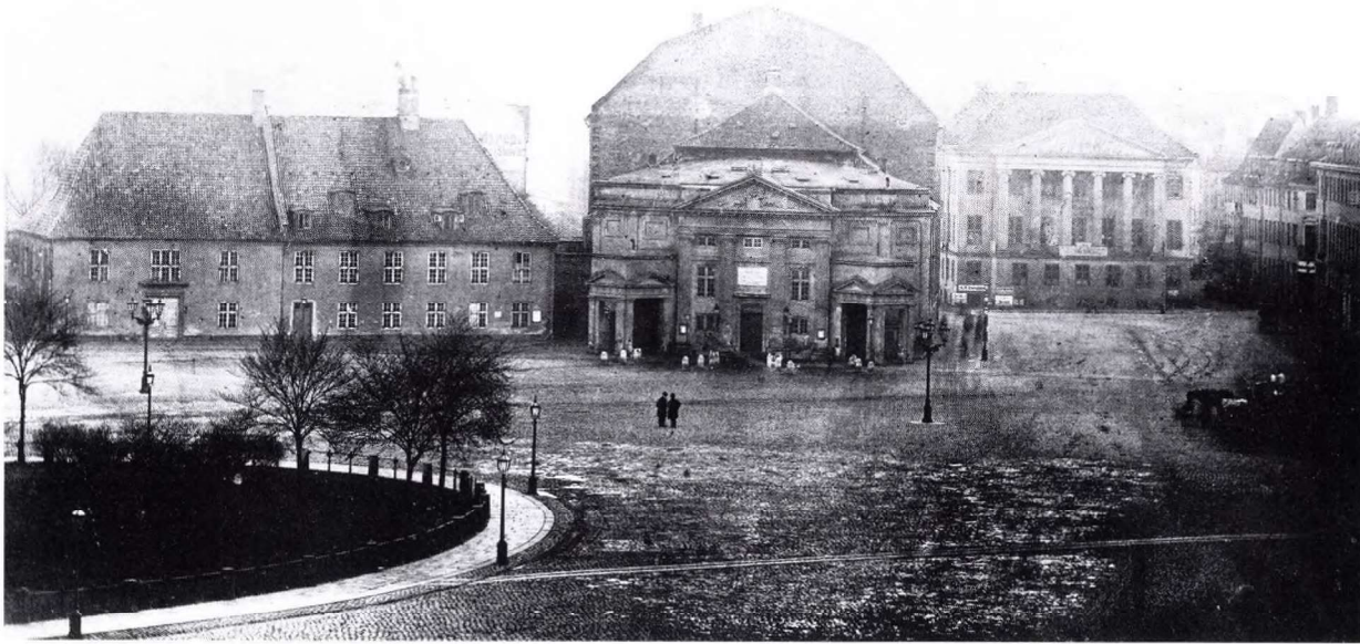
Fig.3. N.S.Nebelongs modernisering af Det kongelige Teaters scene 1857 ødelagde teatrets arkitektur, der rummede ydermure fra Eigtveds oprindelige komediehus (1748) og Harsdorffs ombygninger (1774 og 1792). Til venstre for skuepladsen på Det store Gjæthus' grund blev det nuværende Kongelige Teaters gamle scene bygget i 1873-74. Fotografi af Kongens Nytorv ca. 1870. Københavns Bymuseum.
