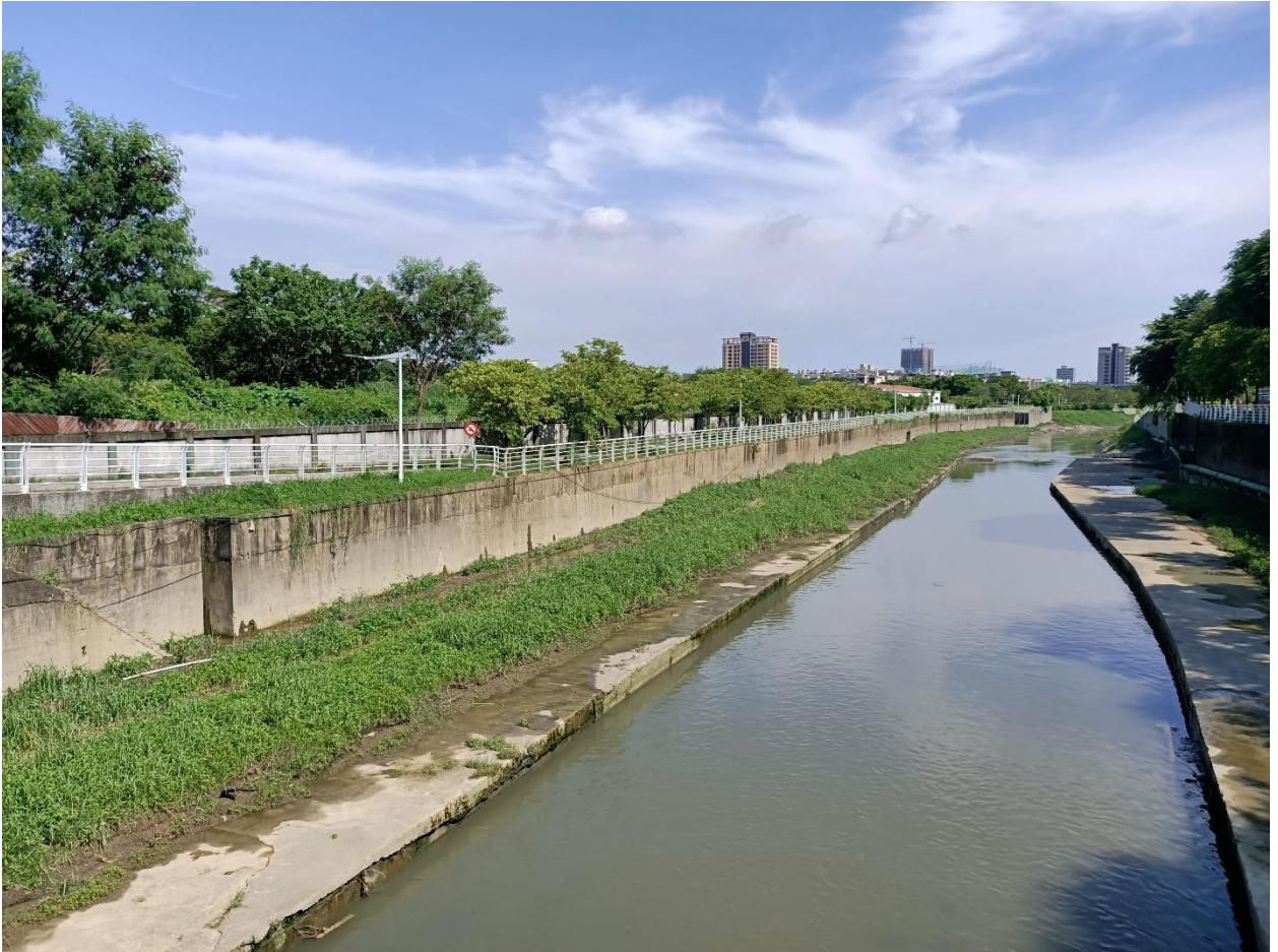
圖 11 鳳山溪鄰近中崙社區段河道現況圖
