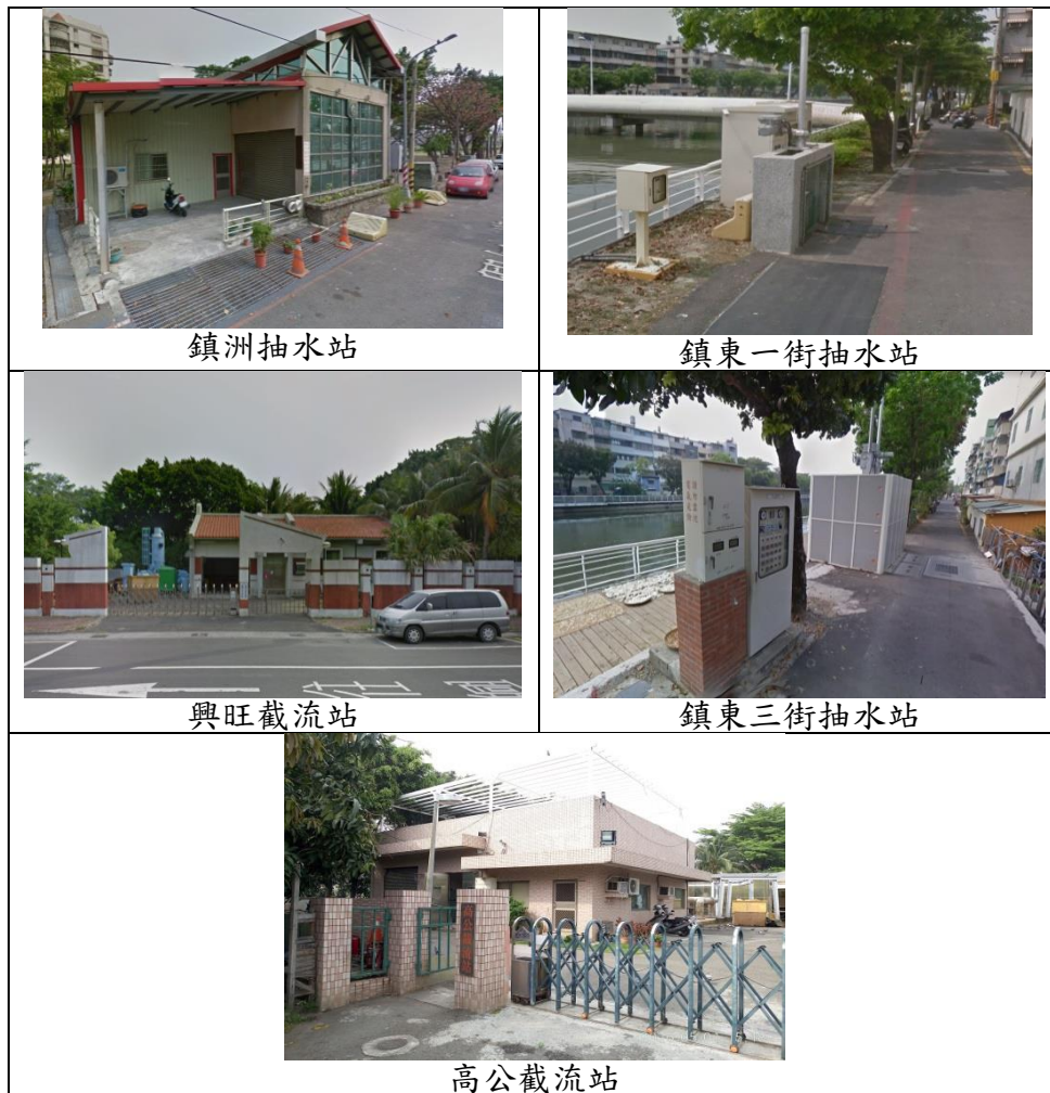
圖 5 前鎮河沿線截流抽水站現況圖
