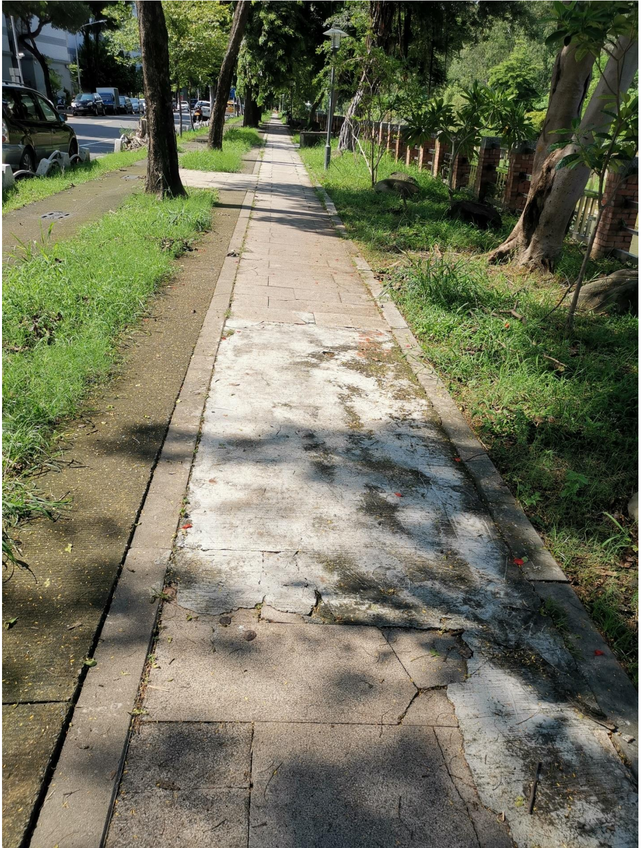
圖 12 中崙社區範圍河道右岸人行道現況圖
