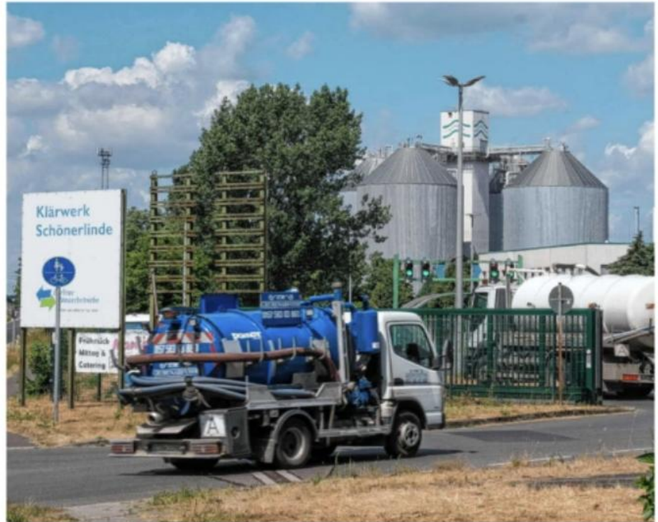
Für die nicht ans Abwassersystem angeschlossenen Haushalte wird die Entsorgung zukünftig noch teurer. Ab sofort müssen die Transportunternehmen die Fäkalien nach Schönerlinde fahren.
