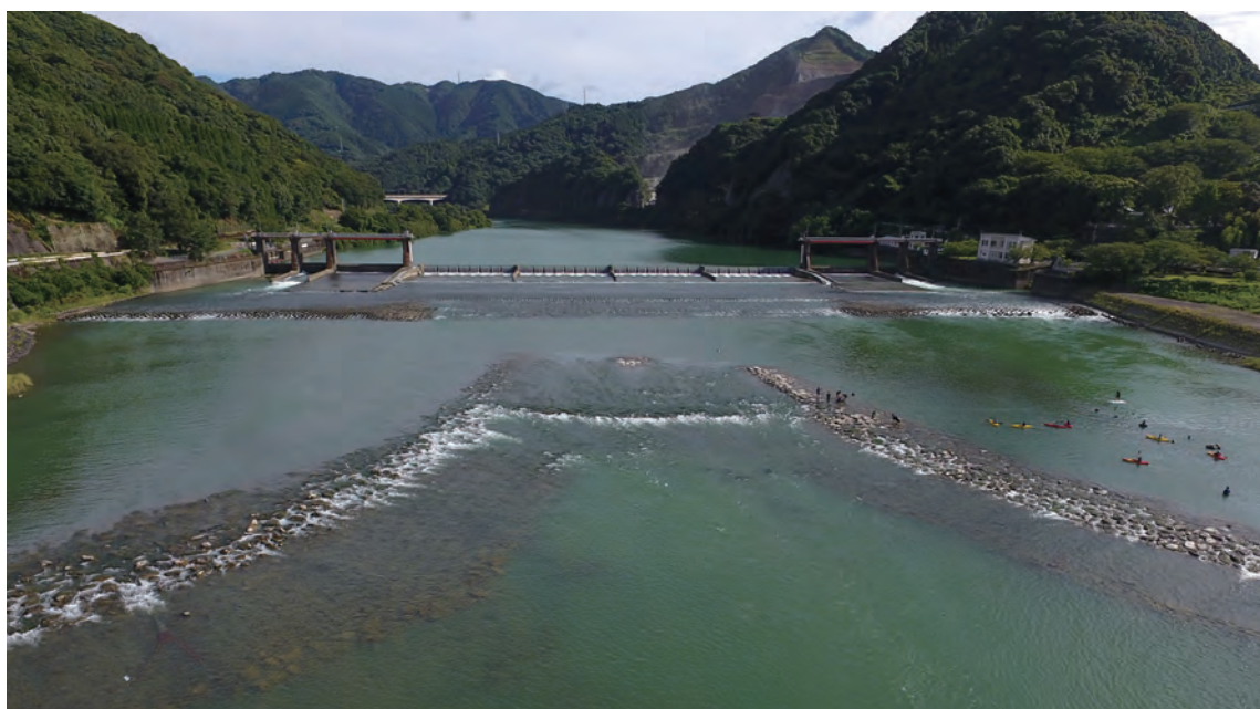
八の字堰(はちのじせき)／加藤清正由来の土木治水技術を駆使した構造物、治水利水機能を有し、かつ鮎の生息環境を創出したもの
