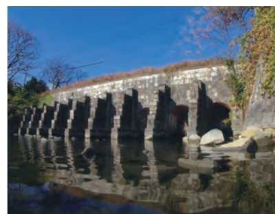
郡築三番町樋門
