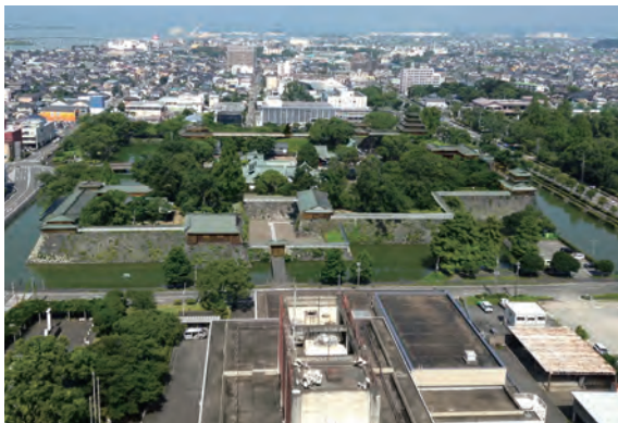
八代城址(松江城址)
