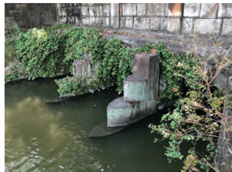
郡築 2 番町樋門／郡築の干拓事業のとき建設された石造りの樋門。文化財に指定されている。
