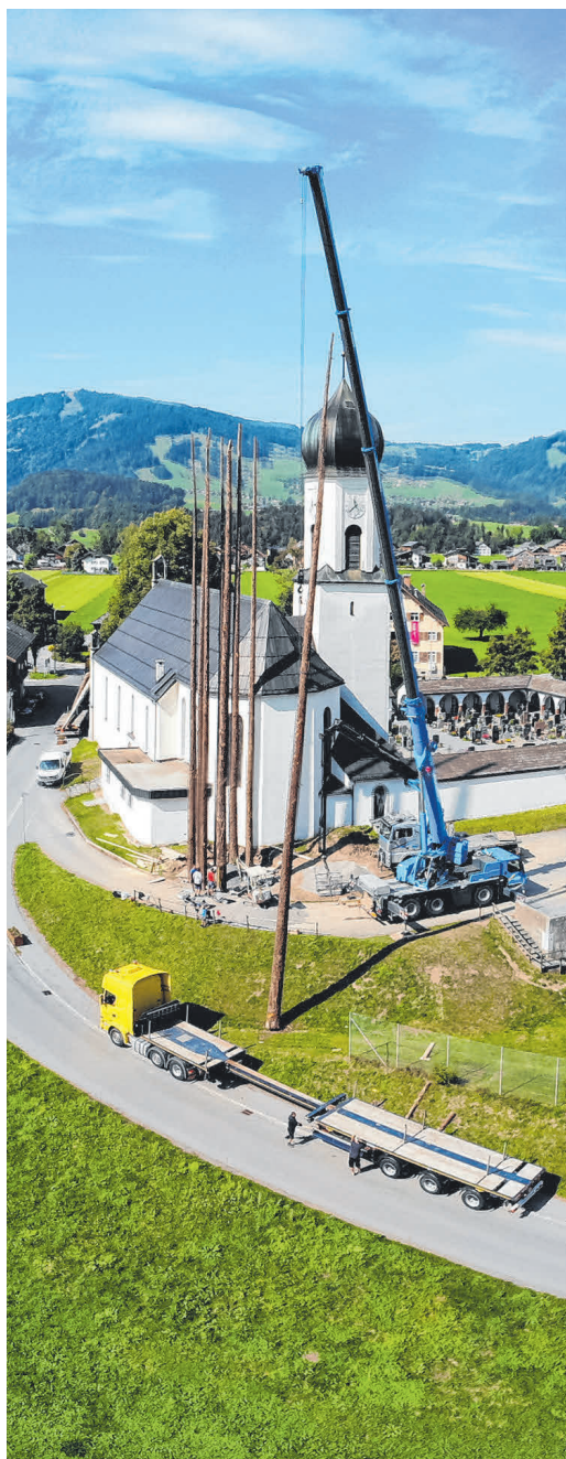
Neben der Andelsbucher Pfarrkirche wurde am Donnerstag im Rahmen von „Handwerk und Form“ ein zweiter Turm aufgebaut.
