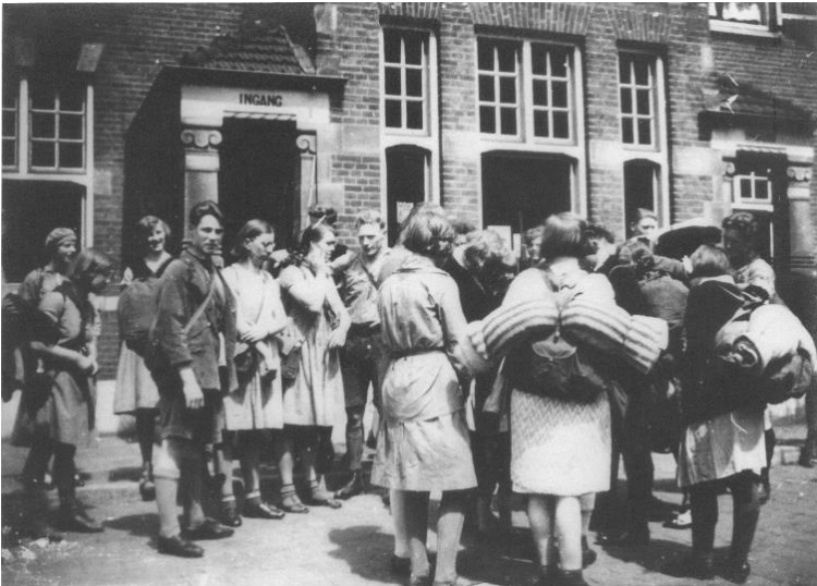
1939 – Tussenstop op station Heerlen
