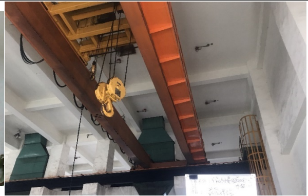
固定式起重機除鏽油漆
