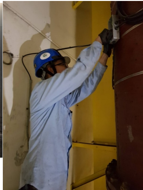
進水抽水站夾管式流量計更新
