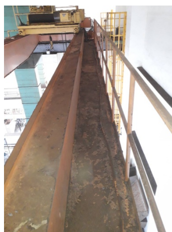
說明：南前天車欄杆
