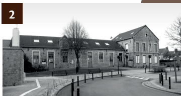
2 MAISON DE QUARTIER CENTRE
