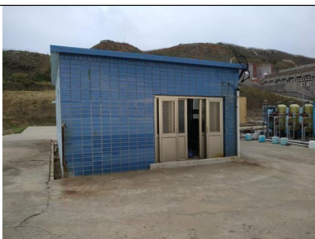
中途之家修繕-結構補強
