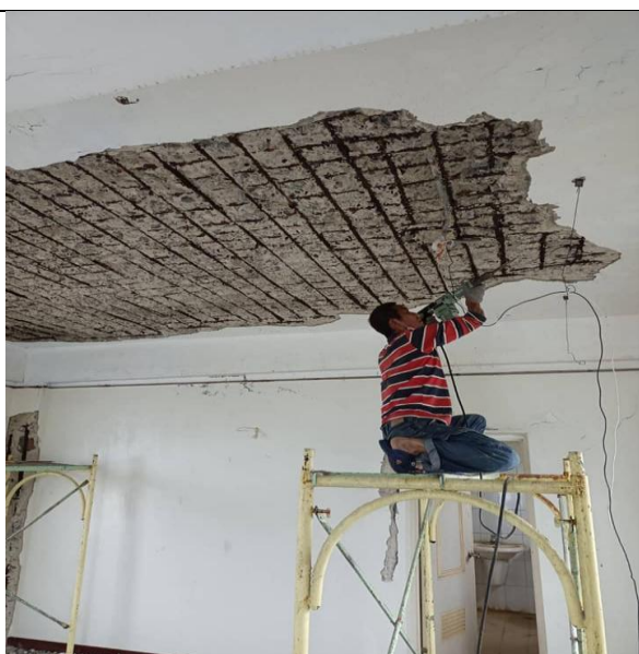
中途之家修繕-結構補強
