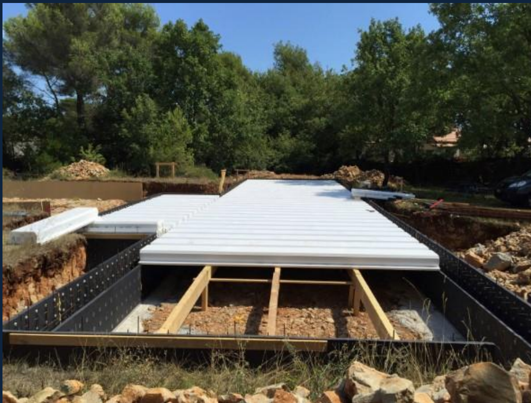
Mise en œuvre des dalles sur vide sanitaire posé sur filaire.
