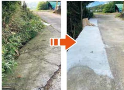
崩れかかっていた道路が補修され通りやすくなりました
