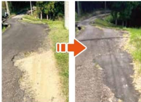
道路の補修工事ができました
