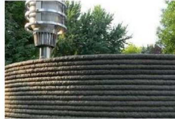
材料：混凝土，無鋼筋
