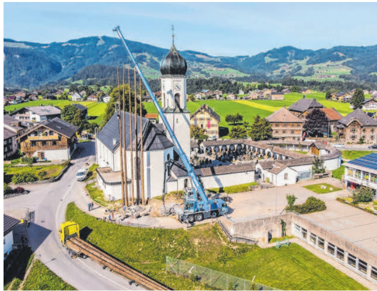
Die Aufbauarbeiten am vergangenen Donnerstag.
