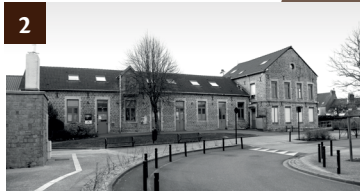
2 MAISON DE QUARTIER CENTRE
