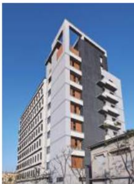
沙鹿順興庫房 設計/長益友室內裝修 施工/坂茂綠能工程 校舍+新粒散布 JQ-500 T4001/T6013/T2001/T4703
