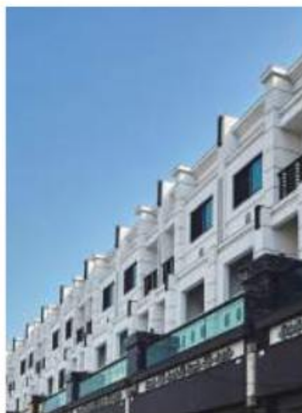
東興御園川 施工/坂茂綠能工程 柚子肌 JP-100 T1000
