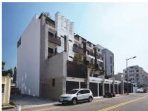
台中南屯透天 施工/板茂綠能工程 柚子肌 JP-100 T2005/T5001/T5454
