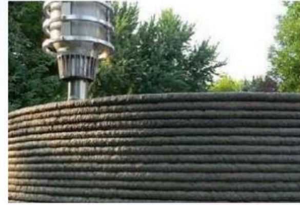
材料：混凝土，無鋼筋
