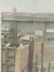
Toute nouvelle maison doit répondre à certains critères.
