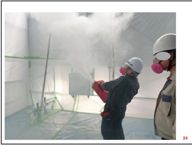
密閉養生空間に特殊な煙の発煙装置でテスト
