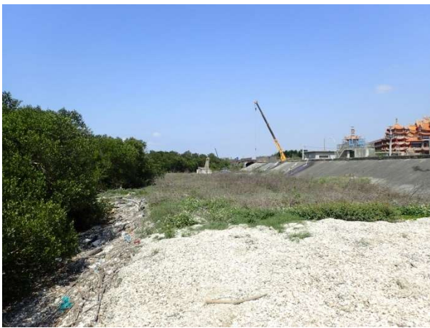
計畫範圍內的紅樹林及蚵殼堆積灘地現況
