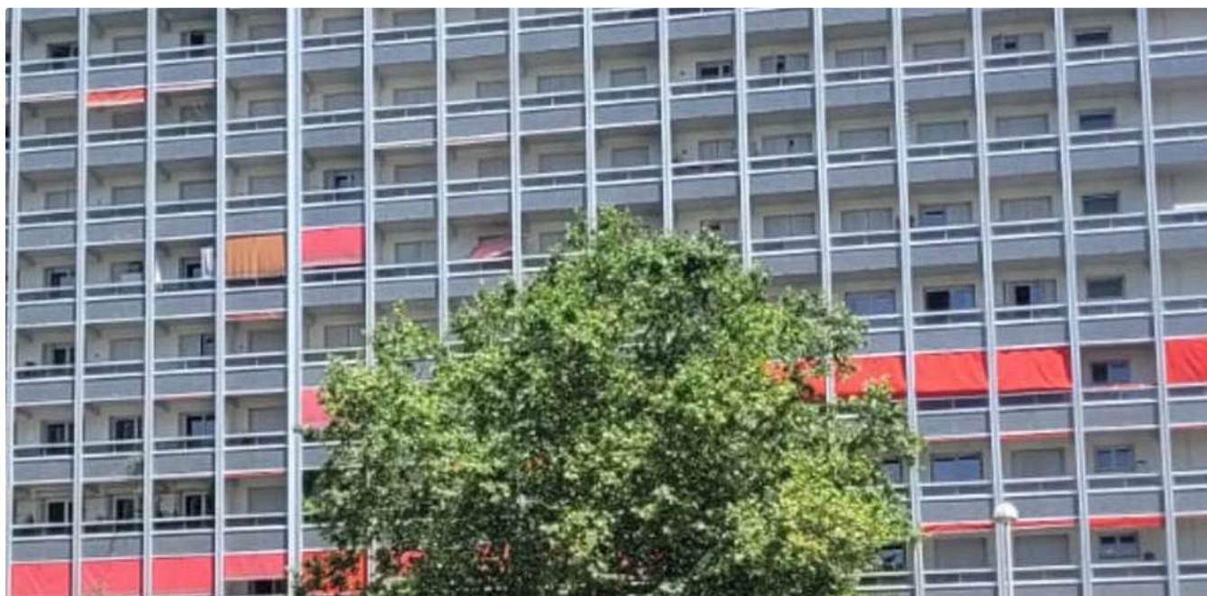
📷 — loggias sans stores, comparaison SACVL étages inférieurs /CFL étages supérieurs
