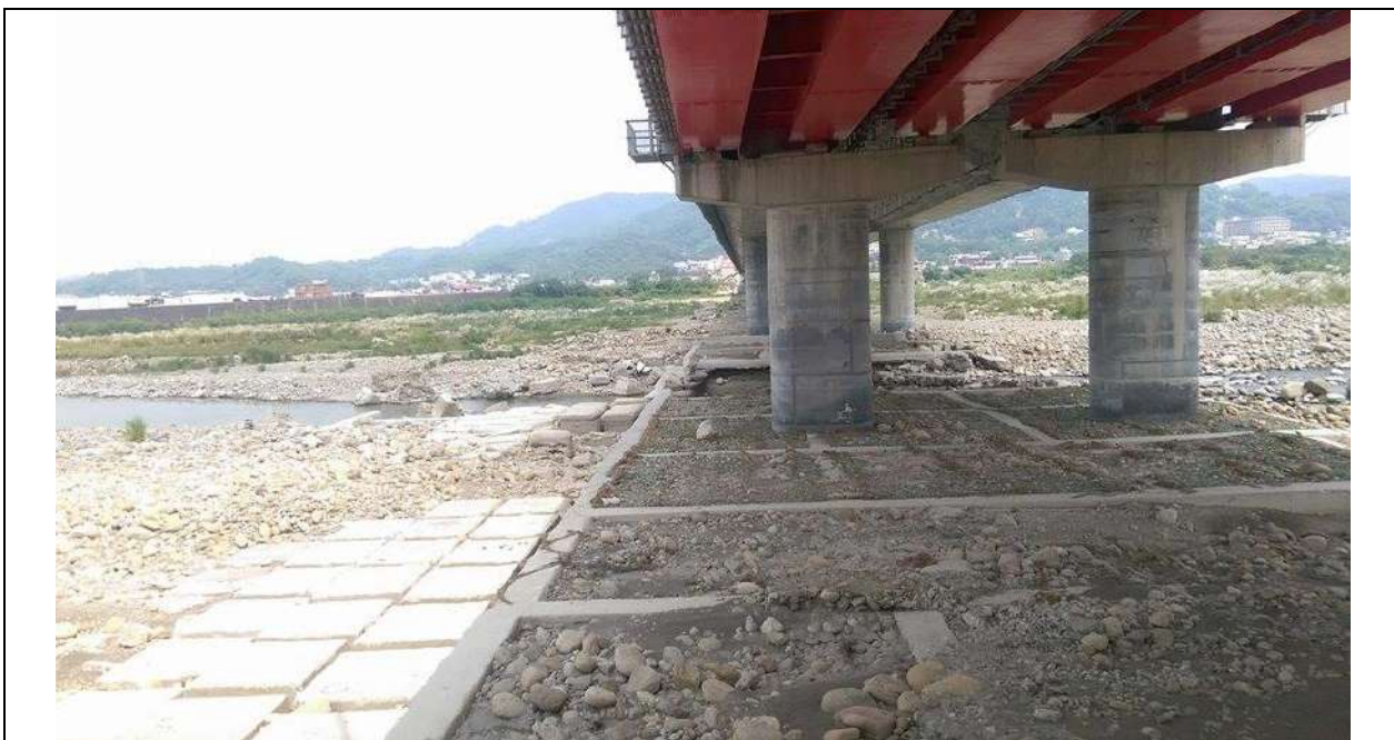
(a)調查樣站現況環境照-竹林大橋下固床工破損
