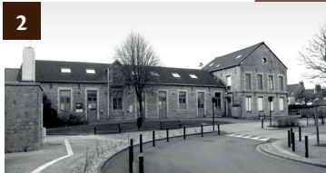
2 MAISON DE QUARTIER CENTRE
