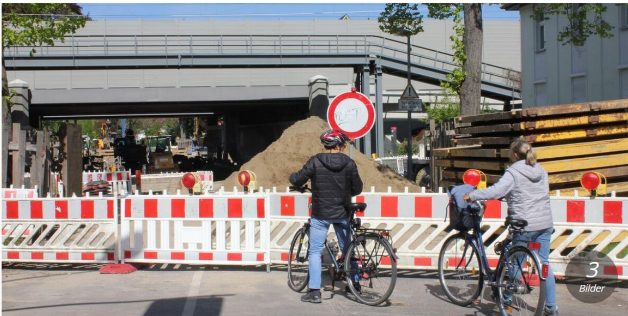
Seit fünf Jahren wird im Bereich der Eisenbahnbrücke über die Pankgrafenstraße am Bahnhof Karow gebaut. Derzeit werden Leitungen erneuert und tiefer gelegt. Voraussichtlich erst im Herbst 2024 wird die Unterführung wieder freigegeben. • Foto: Bernd Wähler • hochgeladen von Bernd Wähler
