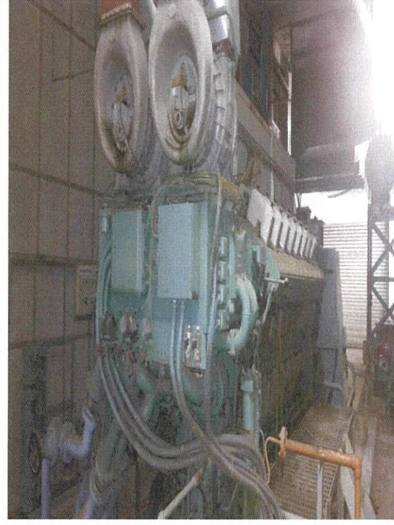
柴油引擎發電機組(施工前)
