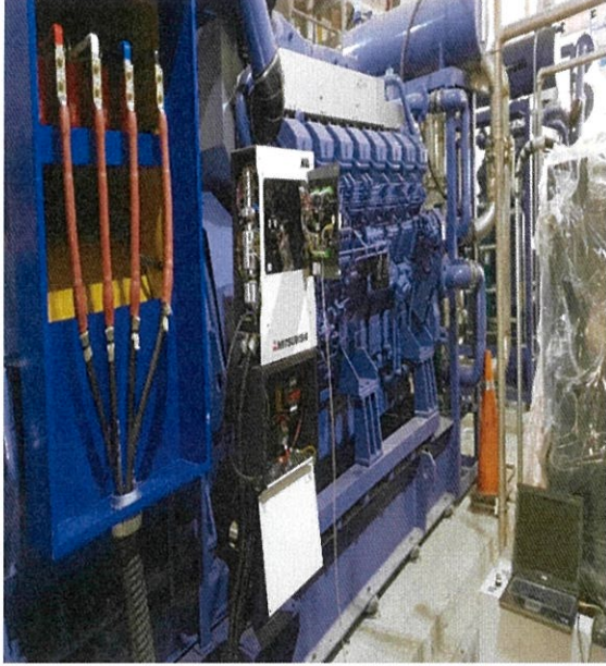
照片內容:G4 及 G5 發電機組操作控制箱
