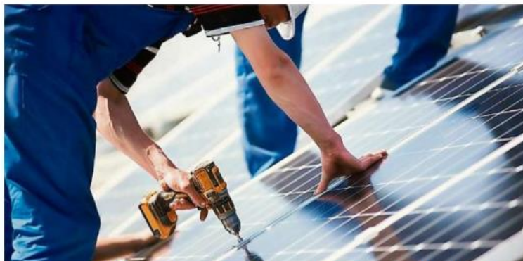
Die Montage von Solaranlagen auf möglichst vielen Berliner Dächern ist eine Klimaschutzmaßnahme, die aus dem jetzt vom Senat beschlossenen Sondervermögen finanziert werden soll. Foto: anatolij_gleb, AdobeStock
