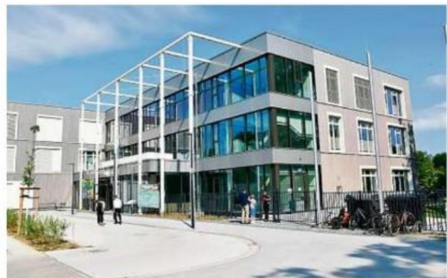
Das neue Schulhaus für die Panke-Schule ist jetzt offiziell der Schulgemeinschaft übergeben worden. Foto: Bezirksamt Pankow/Tobias Schietzelt
