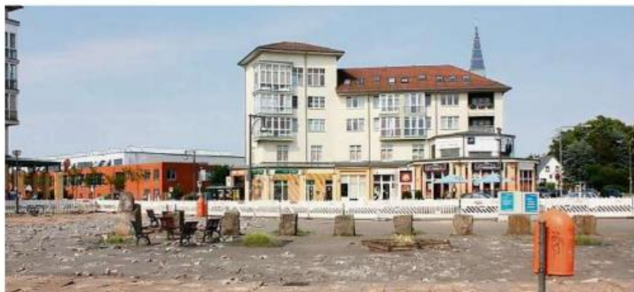
Die Piazza ist inzwischen beräumt und abgesperrt. In den kommenden Wochen wird sie umgestaltet. Im Herbst sollen dann noch neue Hecken und ein Solitärbaum gepflanzt werden. Foto: Bernd Wähler
