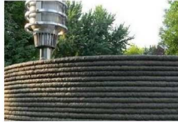
材料：混凝土，無鋼筋
