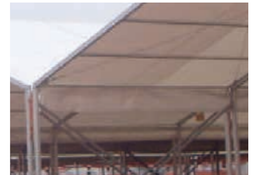
排水槽 Rain gutter
