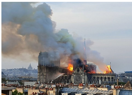
Incendie vu depuis le ministère de l'Enseignement supérieur à 19 h 38.
