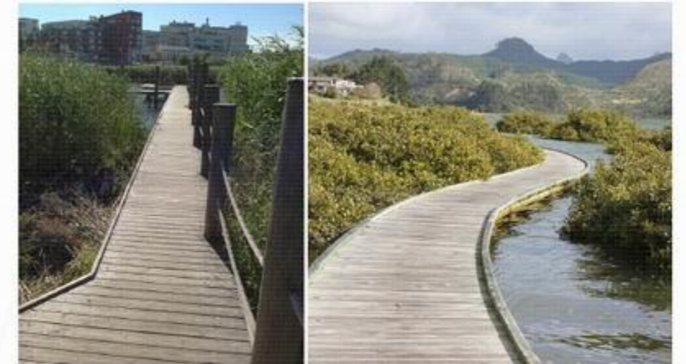
考量低干擾減量原則，評估棧道寬度及單邊欄杆、護欄方式施作
